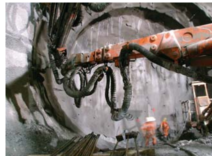
Egyvágányos alagúthajtás Sedrunban
