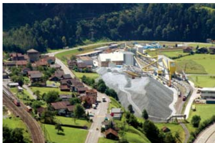
Az amstegi építési helyszín látképe
