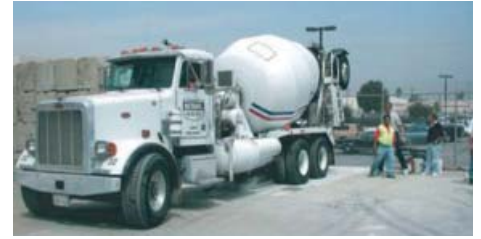
Teli mixer hajt rá a 4x4 beton lemezre négy órával a betonozás után.
